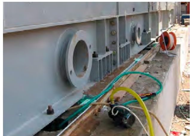
Rys. 1. Nasączenie wodą otworów przeznaczonych na kotwy w fundamencie turbiny i odprowadzanie jej nadmiaru przed nakładaniem spoiny.
